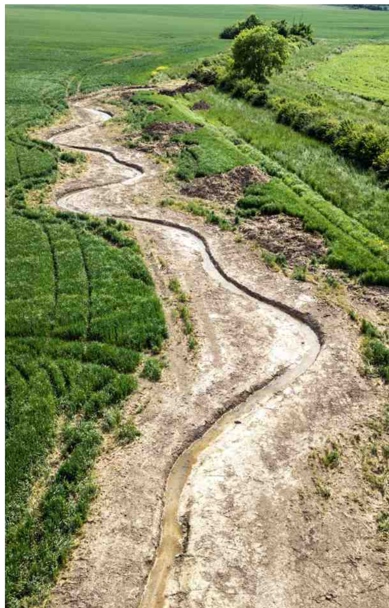
Auparavant, l'eau s'écoulait par un fossé. Celui-ci va être bouché et le syndicat de rivière a créé un ruisseau avec des méandres. Renaud Joubert
